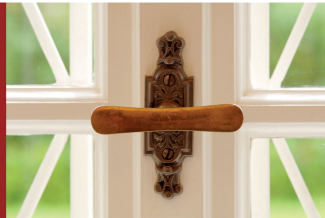
Fensterbeschlag (Foto: LVR-ADR)
